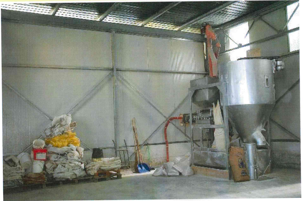
FOTO - 031 - tettoia rimessa attrezzi-cereali-mulino-mangimificio
