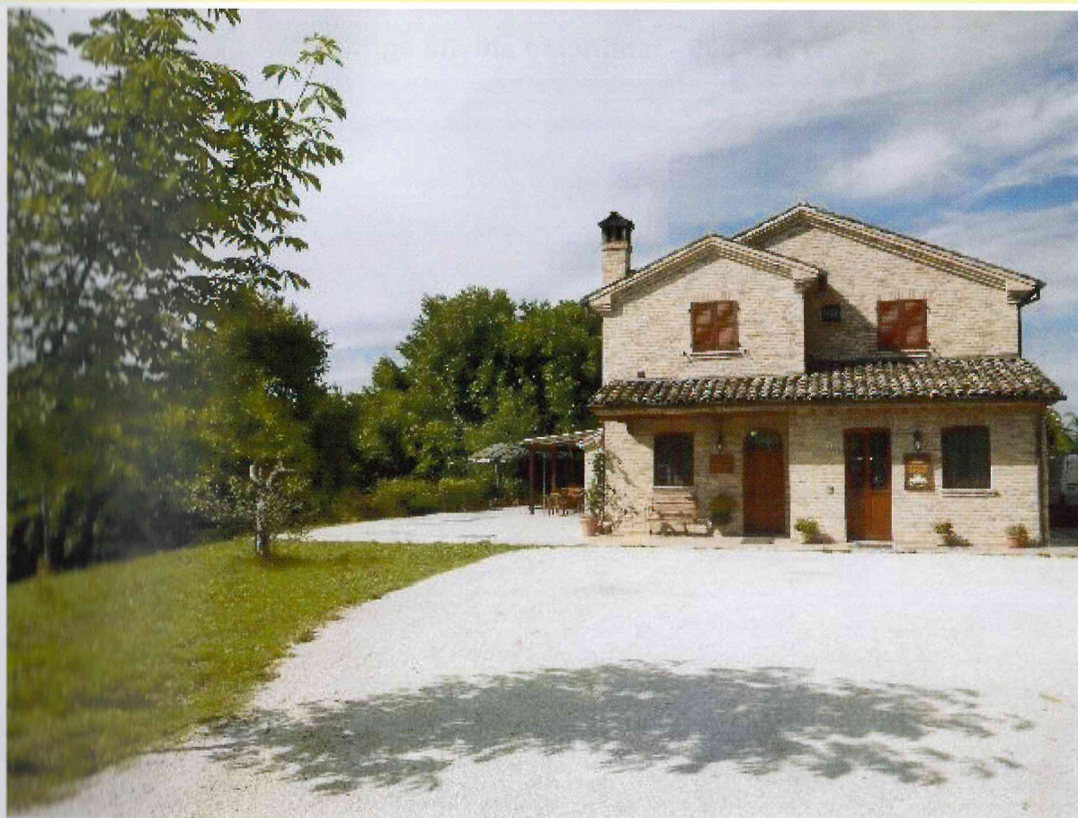
FOTO - 003 - fabbricato attività agrituristica
