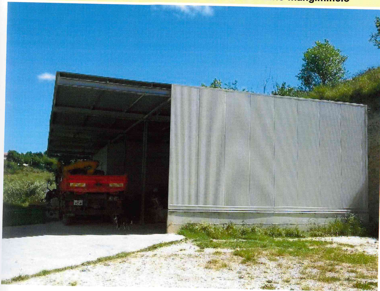
FOTO - 029 - tettoia rimessa attrezzi-cereali-mulino-mangimificio
