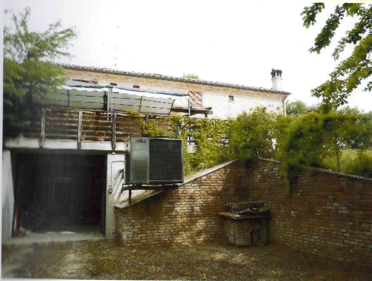
FOTO - 007 - fabbricato attività agrituristica
