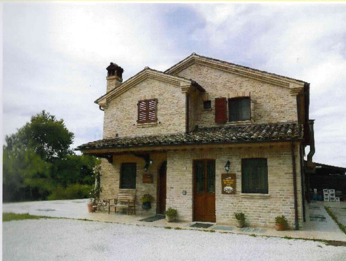
FOTO - 004 - fabbricato attività agrituristica
