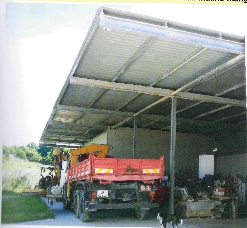
FOTO - 030 - tettoia rimessa attrezzi-cereali-mulino-mangimificio
